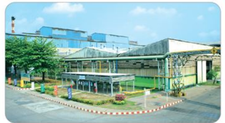
โรงงานสระบุรี
